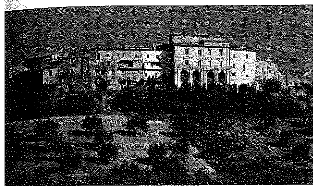
Fig. 2 - Castelbasso, veduta del centro fortificato posto su un'altura a nord del fiume Vomano, di cui si conservano i resti dell'alta bastionatura a scarpa
