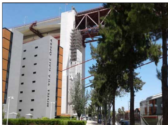
Figure 4. Centro Interpretativo da Ponte 25 de Abril (under construction)
