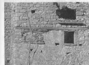
Figura 3 Montebello sul Sangro (Ch), particolare di un «radiciamento» impiegato sia come architrave, sia come rinforzo dell'apparecchio murario in bozze e blocchi di calcare. A sinistra, dettagli fotografici di travi lignee inserite nelle murature (Verazzo 2014).
