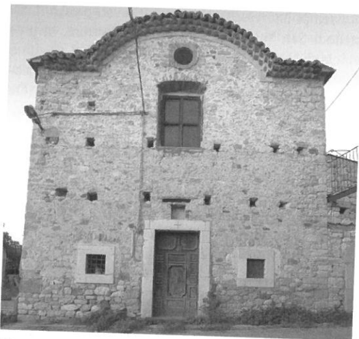
Figura 2 Bomba (Ch), chiesa di Sant'Antonio al ponte, prospetto principale (Verazzo 2014).
