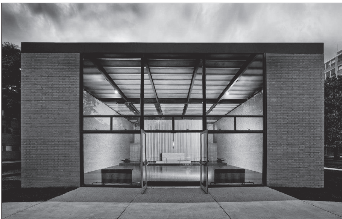
Fig. 8 – Robert F. Carr Memorial Chapel of St. Savior di Ludwig Mies van der Rohe. Foto attuale tratta da <WikiArquitectura>
