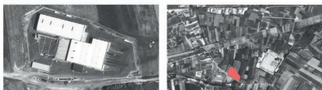
● Aielli (AQ) - TMB - Impianto di compostaggio ACIAM SpA
