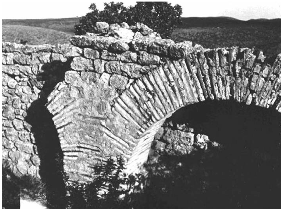
Fig. 11 - Monastero di Mar Gabriel, particolare costruttivo della chiesa (Archivio Bell).
