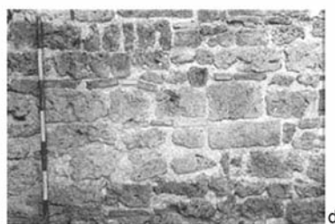
Fig. 41 - Esempi di petit appareil , a. S. Maria dello Spineto (CH); b. S. Maria in Palatio (CH); c. Roma, S. Paolo f.l.m. muro del monastero (prima metà VIII sec.) (da SPERA-ESPOSITO-GIORGI 2011); d. S. Vincenzo al Volturno (da GOBBI 2007).
