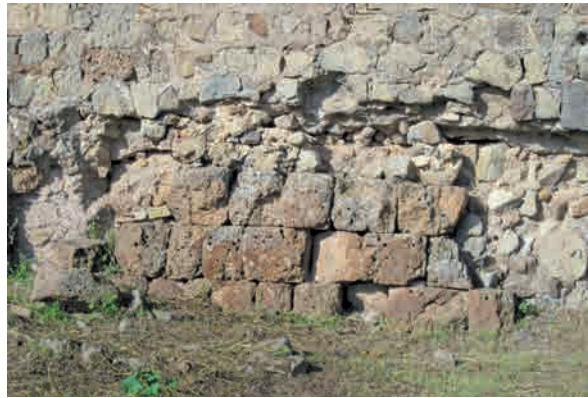
Fig. 15. Cencelle: resti di muratura di età etrusca inglobati nelle fortificazioni di Leone IV
