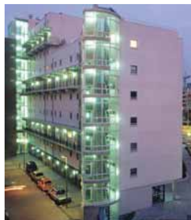
Edificio in Kruisplein, Rotterdam, 1980. Si notano i ballatoi di distribuzione sul retro Building in Kruisplein, Rotterdam, 1980. Here we note the balconies used for circulation at the rear
