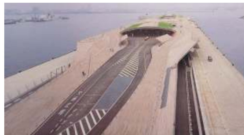
fig. 28 Yokohama, il terminal crociere di FOA
