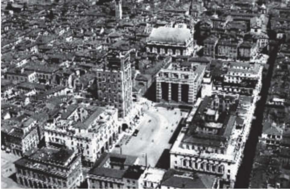
Fig. 7. The new Piazza della Vittoria in Brescia, dated aerial photo. ( www.bresciavintage.it )
