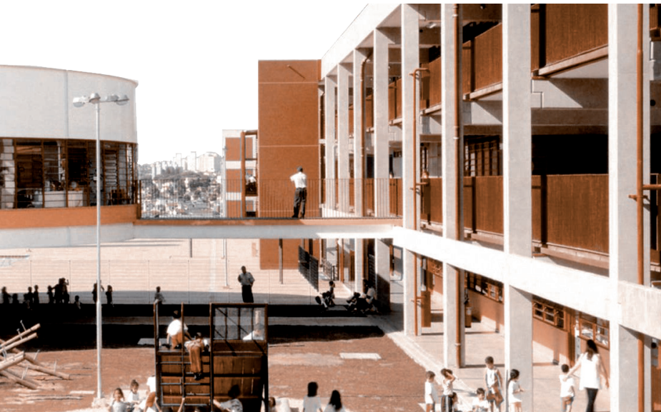
Fig.1 Centro di Educazione Unificata a San Paolo.
