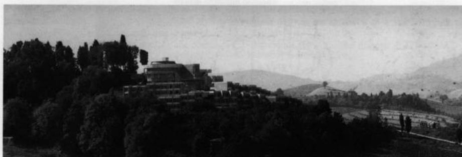
Veduta d'insieme del Collegio del Colle nell'ondulato paesaggio circostante.
