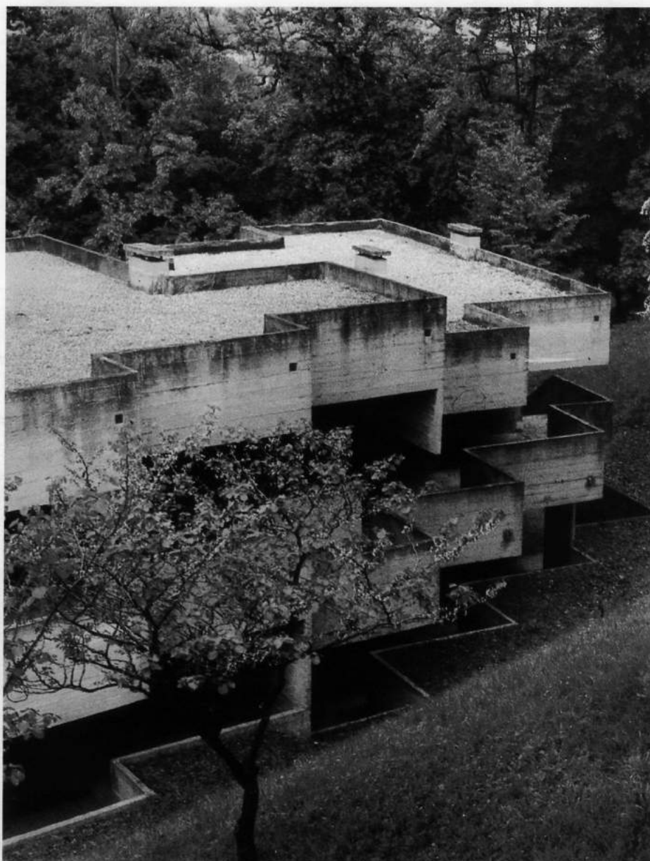
Vedute dell'inserimento nel contesto delle residenze del Collegio del Colle di Urbino. Il trascorrere degli anni ha aumentato l'integrazione tra il costruito e l'ambiente.
