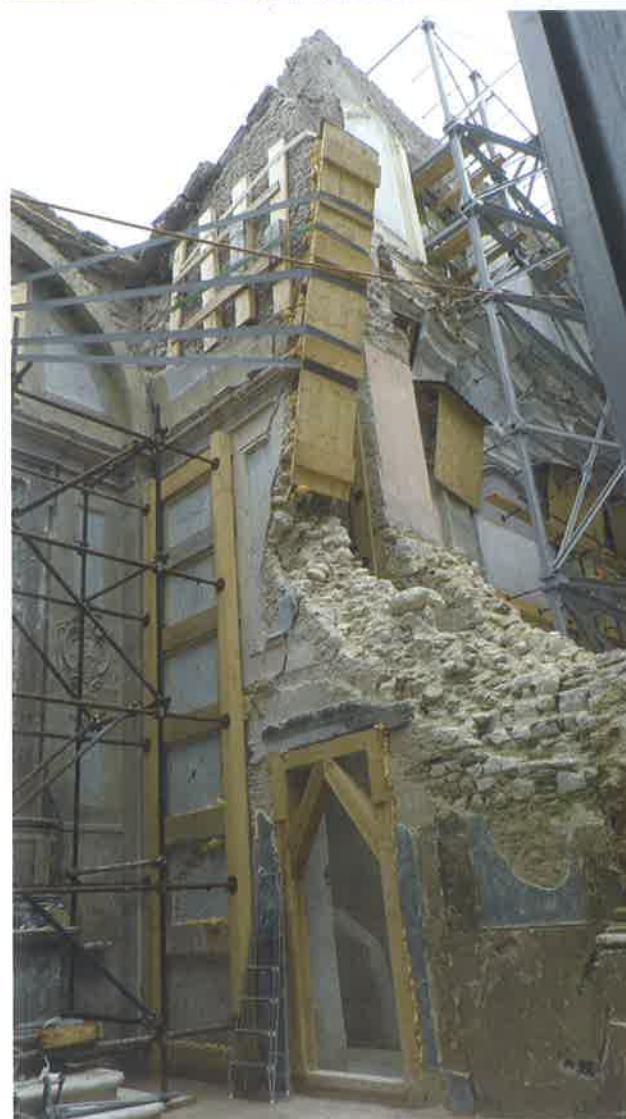
Figg. 17, 18 - L'Aquila. S. Maria di Paganica, i resti della cupola e particolare dell'apparecchio murario su cui impostava la cupola (foto dell'A.)
