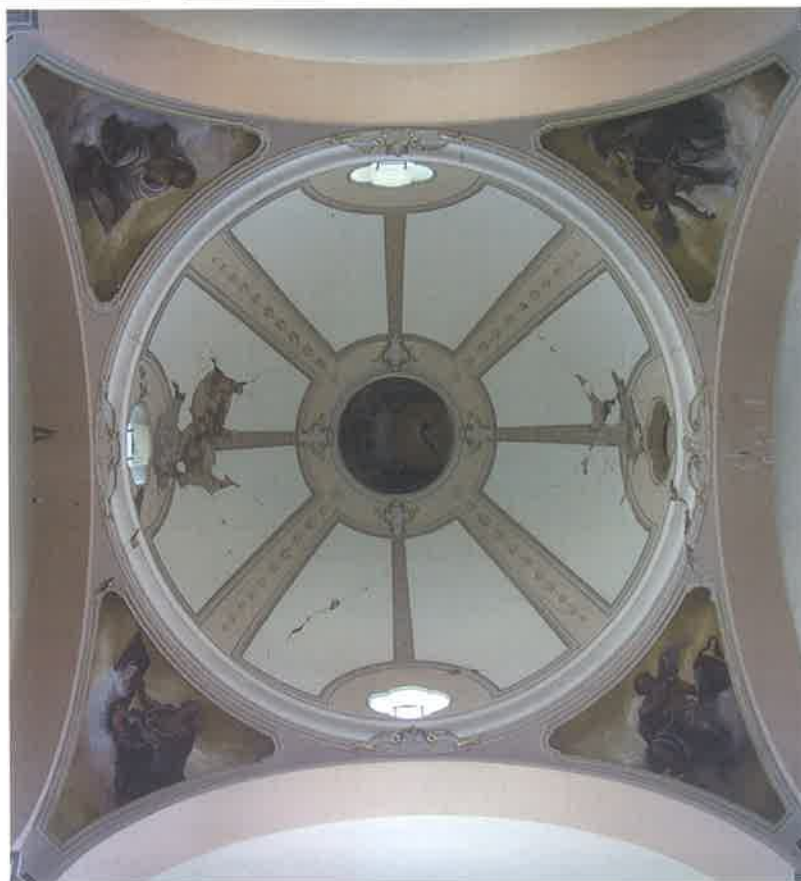
Fig. 20 - Loreto Aprutino. S. Francesco, archi trasversali di rinforzo alla volta della navata (foto dell'A.)
