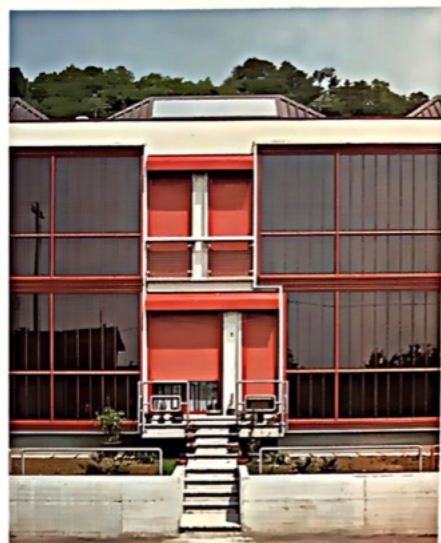
Fig. 245 Sistema solare passivo, Barra-Costantini a Marostica.
