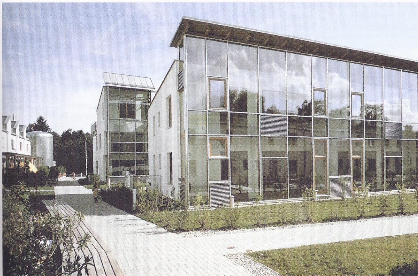
G. Moos, Edifici residenziali, Salisburgo - Austria
