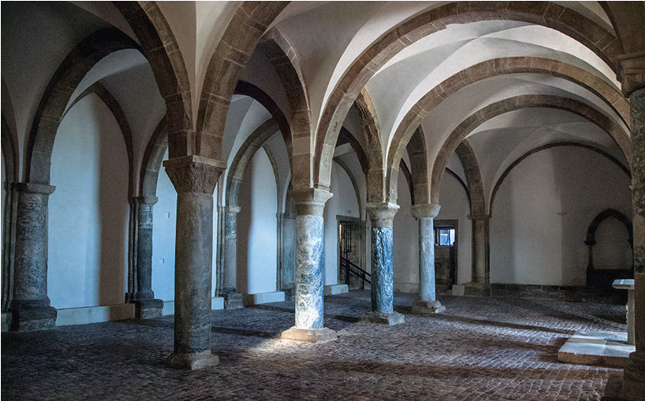
S. Giovanni in Venere: panoramica della cripta con le numerose colonne antiche in granito reimpiegate nella struttura medievale (foto F. Nestore).
