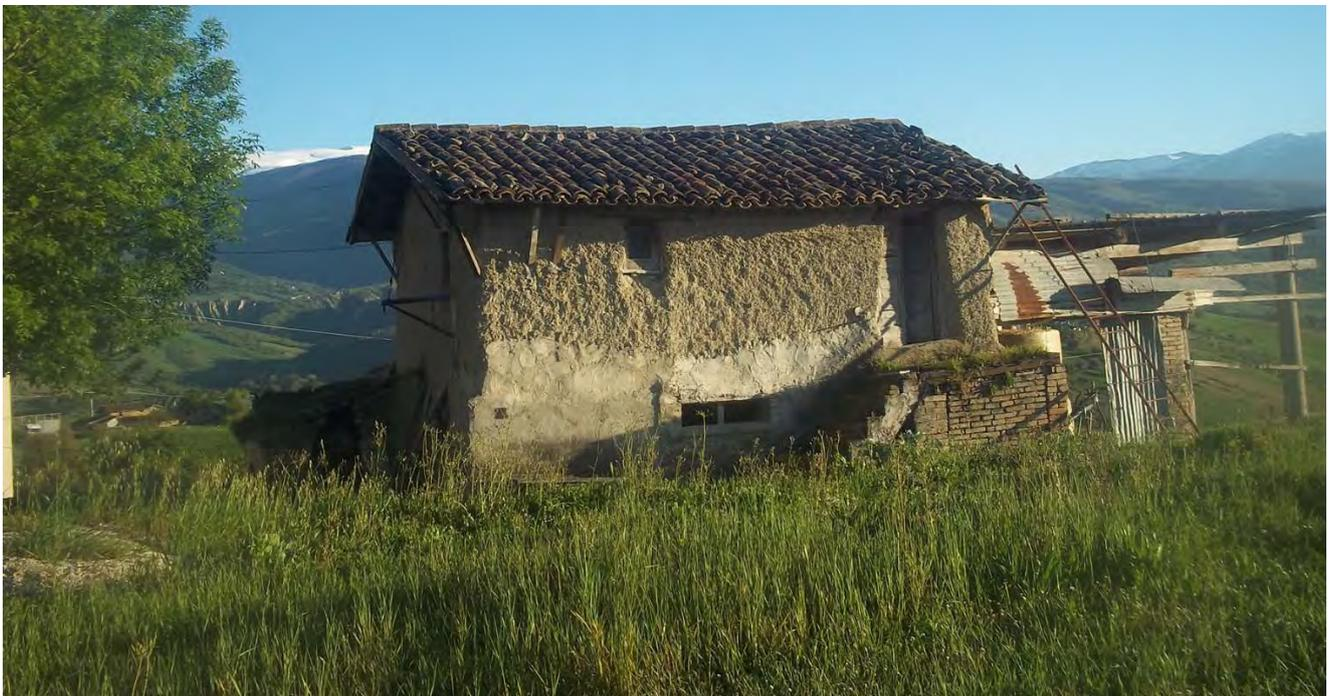
Fig. 3 – Manoppello (Pe), casa rurale isolata in terra cruda nel paesaggio coltivato – Fonte: foto di Ambra Lattanzio
