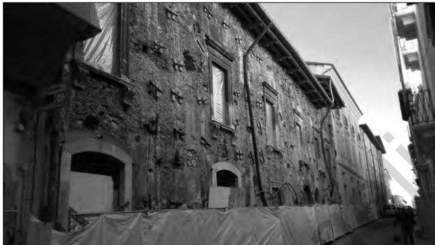
Fig. 2 – L'Aquila: restauri in corso lungo via Garibaldi, 2017 (© Claudio Varagnoli).
