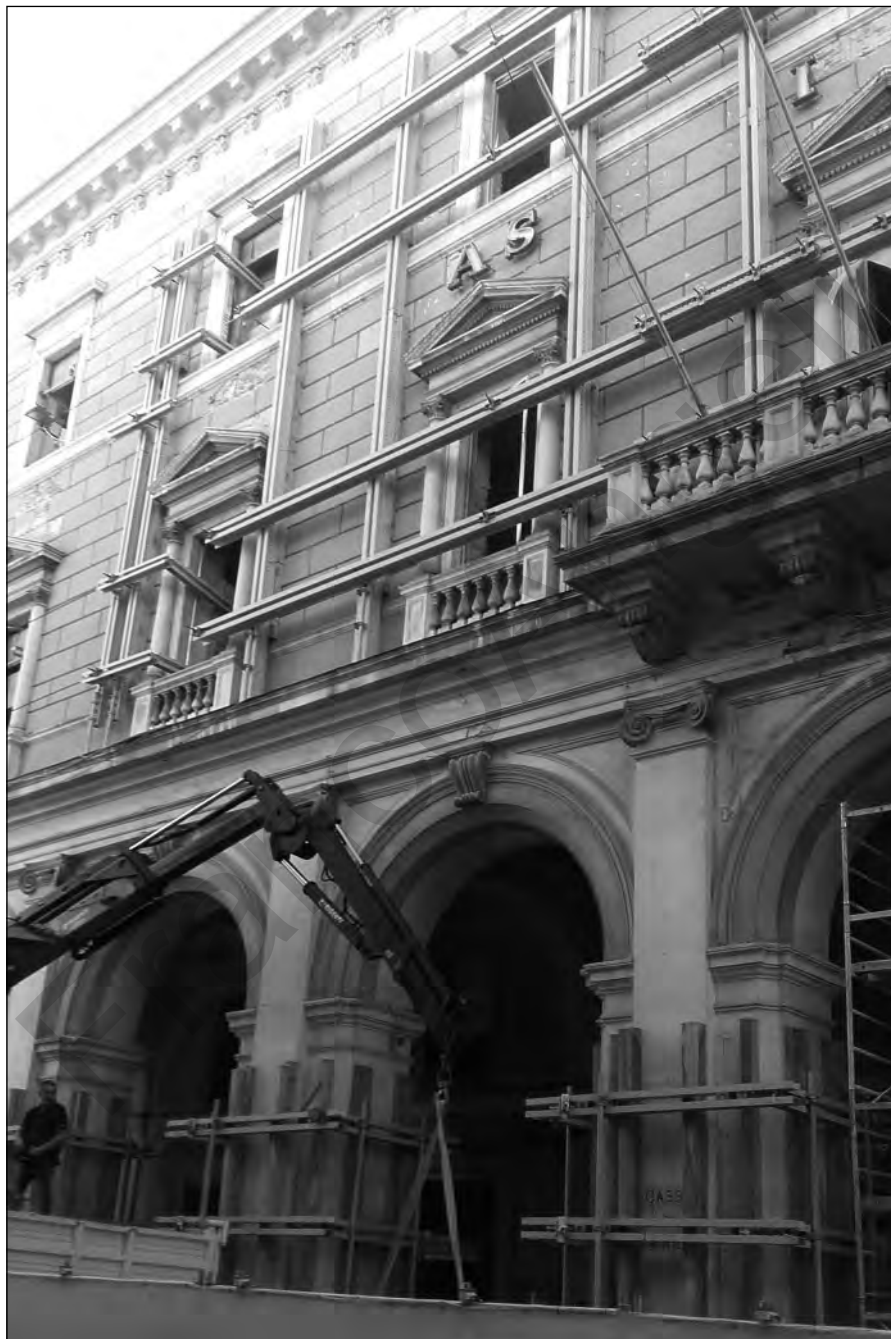
Fig. 1 – L'Aquila: la ricostruzione degli edifici lungo corso Vittorio Emanuele II, 2016 (© Claudio Varagnoli).
