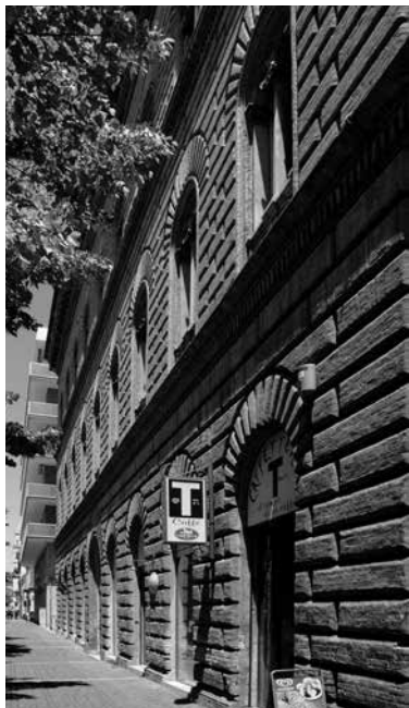
Fig. 38 – Pescara, palazzo Perenich, foto attuale della facciata
