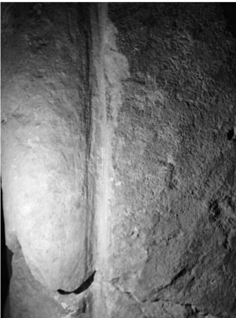
Fig. 33 Tracce di impiego di una sgorbia molto larga e con una curvatura minima.
