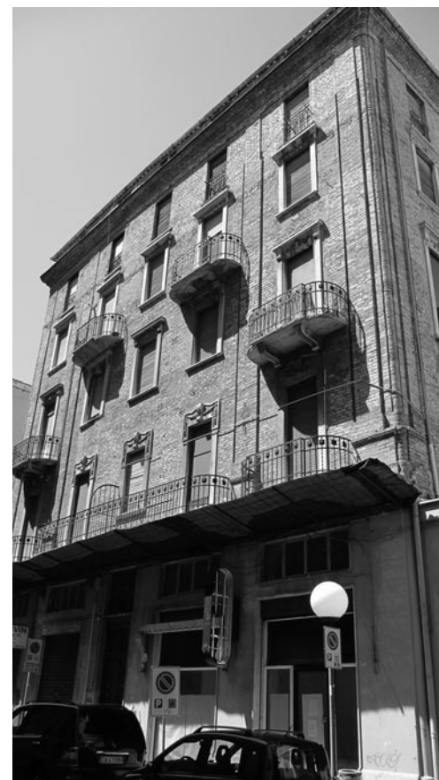
Fig. 36 – Edificio censito nell'ambito urbano della "città consolidata" in categoria A2 oggetto di una prossima operazione di demo-ricostruzione.
