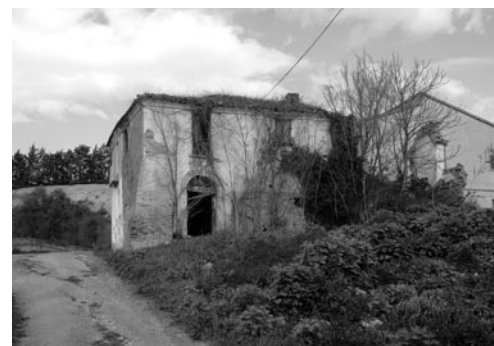
Fig. 28 – Fabbricato rurale censito nell'ambito urbano Colli-Castellamare Adriatico, recentemente demolito (2018).
