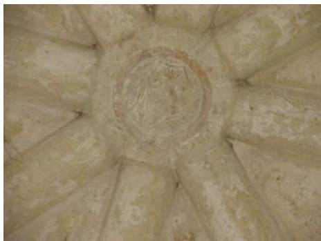
Fig. 3. Particolare della chiave blasonata con stemmi nella volta della torre posta a nord-est.
