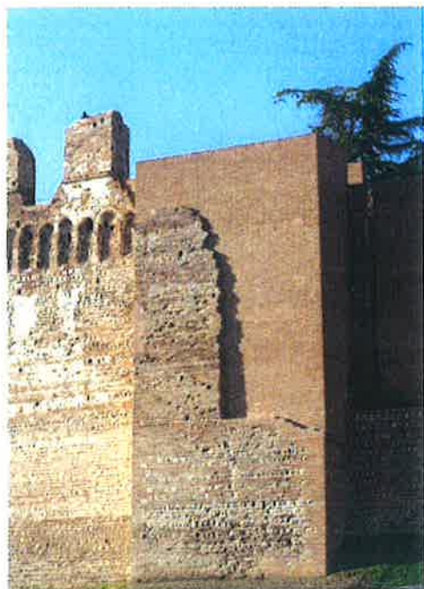
Fig. 4- Cittadella (Padova). Reintegrazione muraria (P. Valle, 2005-2013)
