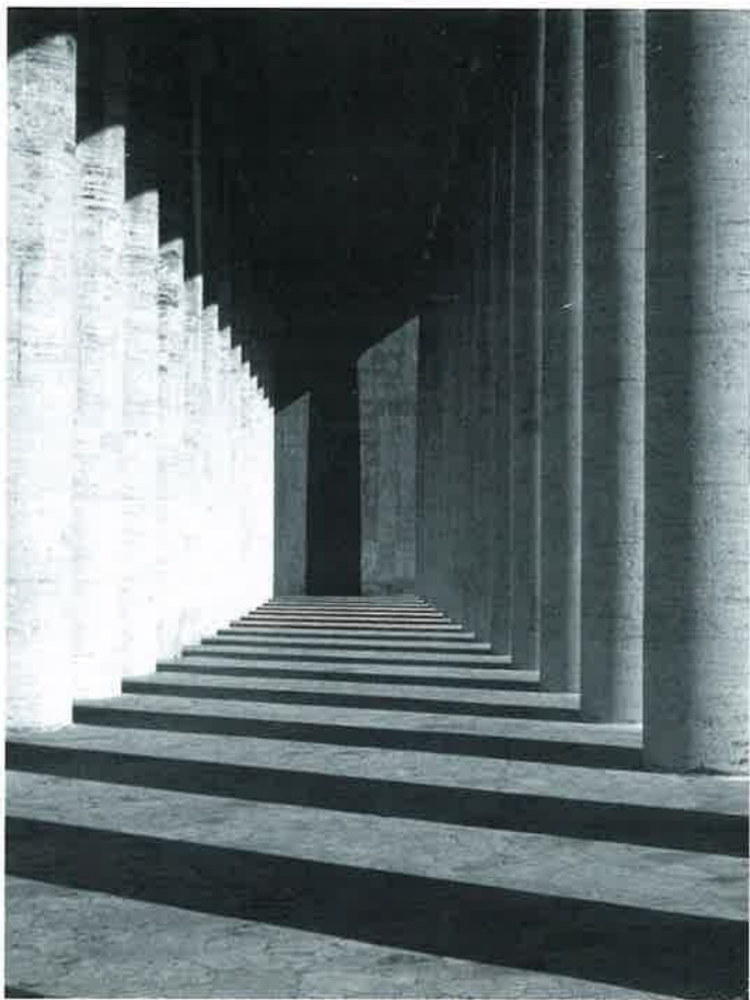
Fig. 3 - Roma, museo della Civiltà romana; P. Aschieri, D. Bernardini, C. Pascoletti, G. Pressutti, 1939-1941 (foto dell'autore, 2005).
