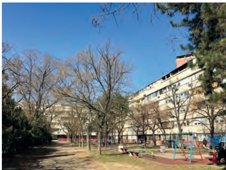
14e. Nuova Belgrado. Block 21. Edificio à redents. Interno delle corti
