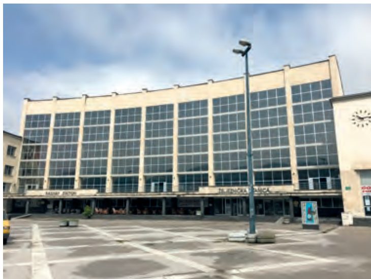
33a. Bogdan Stojkov e Dušan Smiljanić, Stazione di Sarajevo. Veduta facciata esterna, 1948-52
