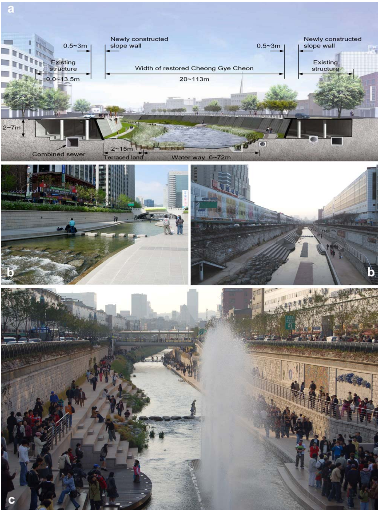
(Fig. 8) Cheong Gye Che Seoul. Progetto: Cheongsuk Eng., Saman Eng. e Dongmyung Eng. + SeoAhn Total Landscape. 8a. Sezione tipo dell'intervento di restauro; 8b; Vedute dell'alveo del fiume restaurato tre le preesistenze edilizie e infrastrutturali; 8c. Una nuova fase co-evolutiva per la storia del fiume. Fonti: Wikimedia Commons, Seoul Metropolitan Government.
