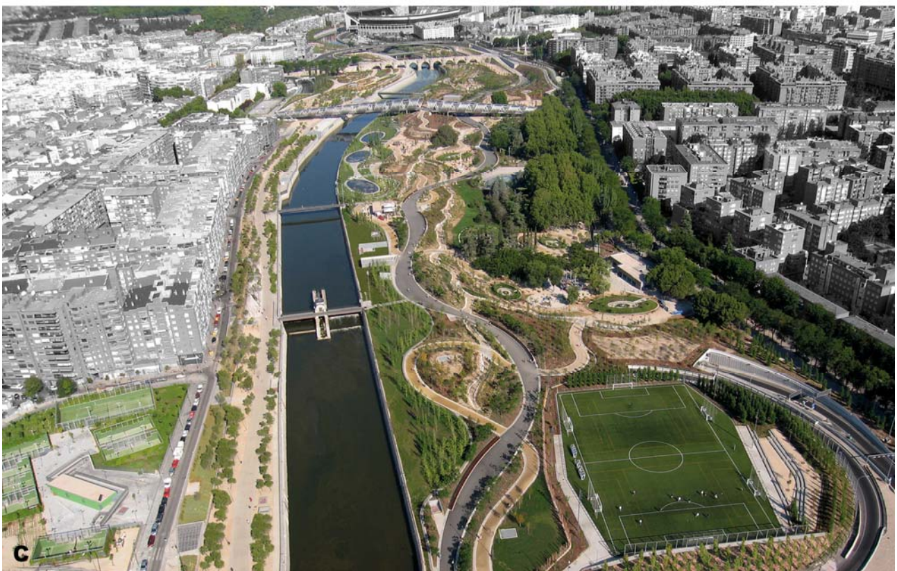
(Fig. 7) Parque Río Manzanares , Madrid. Progetto: WEST 8 + Burgos & Garrido + Porras & La Casta + Rubio Álvarez-Sala. 7a. Le aree di progetto, prima e dopo l'intervento; 7b. Sezione lungo la M-30 interrata con le aree parco sovrapposte del Salón de Pinos e veduta dell'innesto del Parco con l' Avenida de Portugal ; 7c. Il sistema degli interventi nel tratto di Arganzuela Park . Fonte: Municipality of Madrid, West 8.
