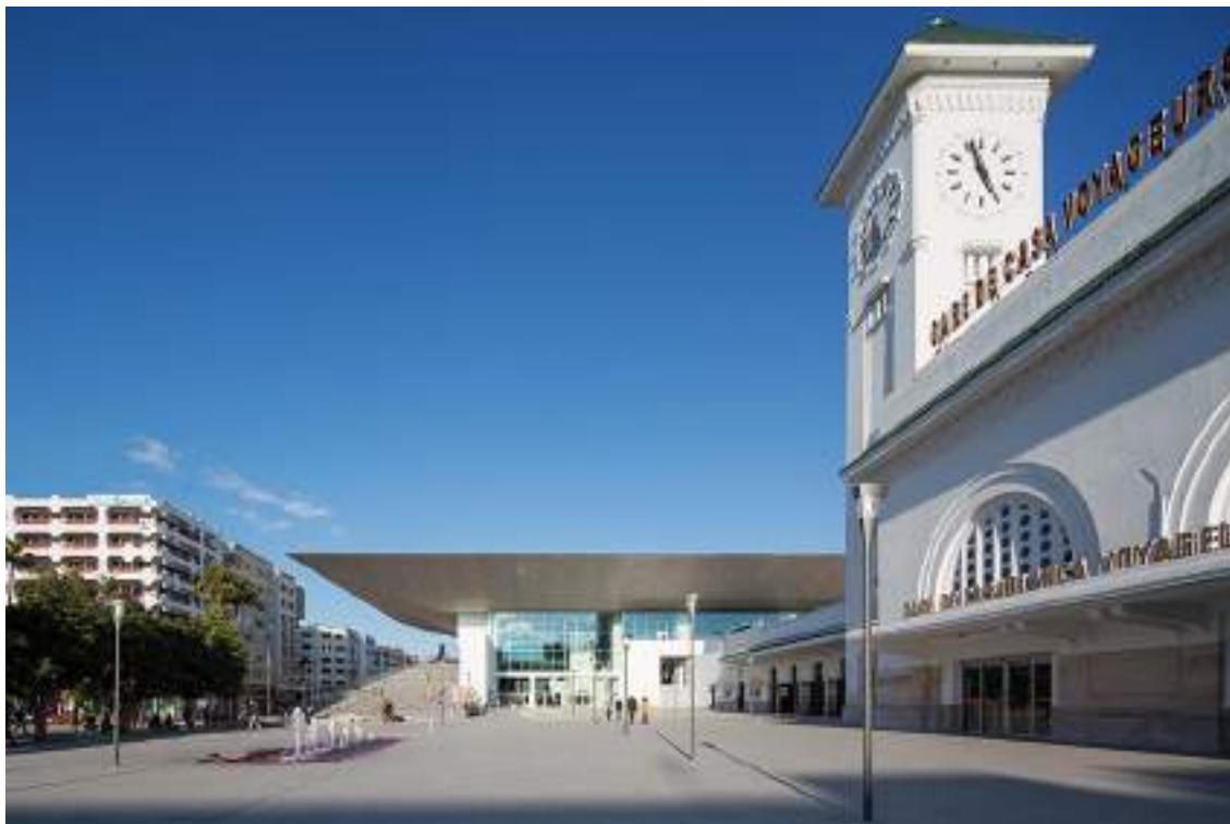
(Fig.7) La nuova stazione Casa Voyageurs – vista dalla piazza Sidi Mohamed
