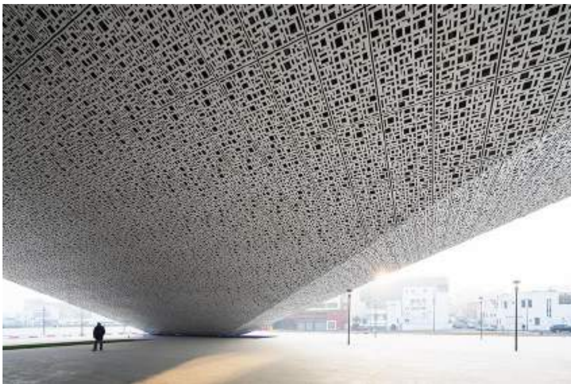
(Fig.6) La nuova stazione Casa Voyageurs – vista dell'ingresso Nord
