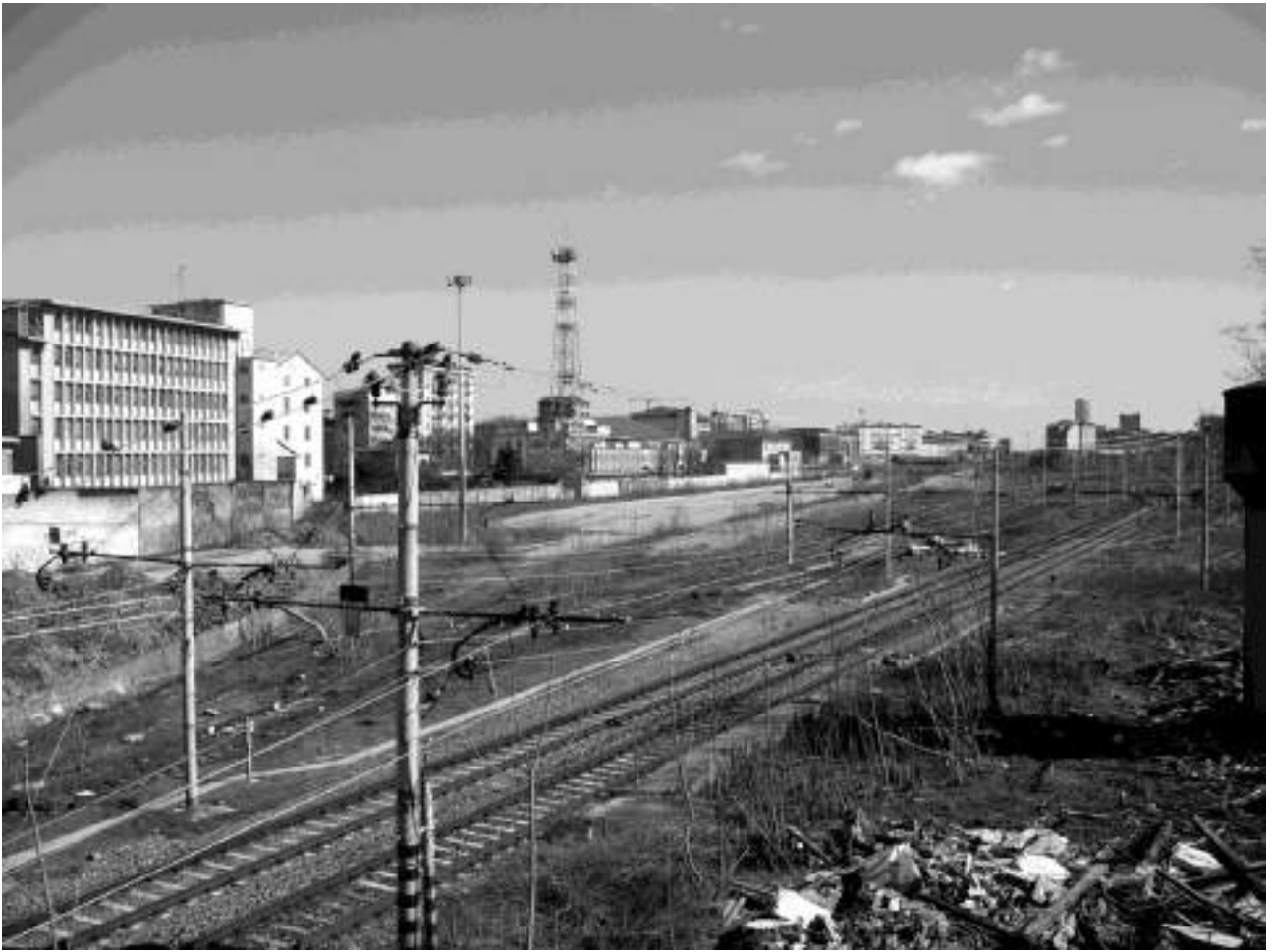
(Fig. 8) Lo scalo di Porta Romana (fonte: L. Montedoro 2011)
