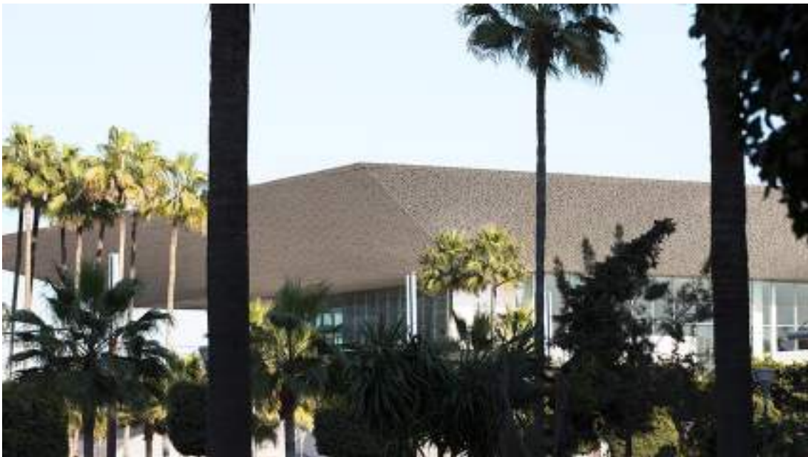
(Fig.8) La nuova stazione Casa Voyageurs – vista da sud
