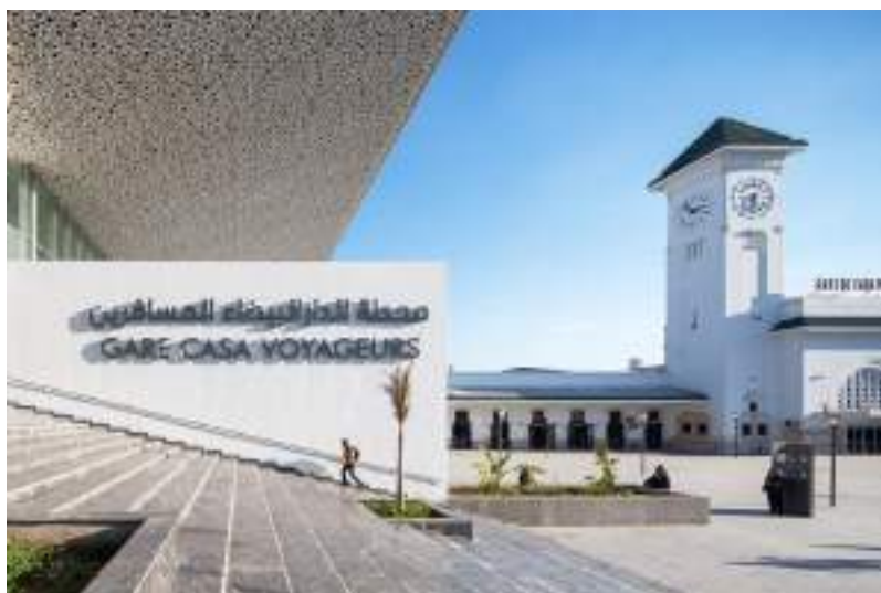
(Fig.1) La nuova stazione “Casa Voyageurs” di Casablanca
