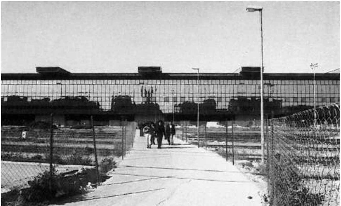
(Fig. 6) - Vista del nuovo impalcato ferroviario
