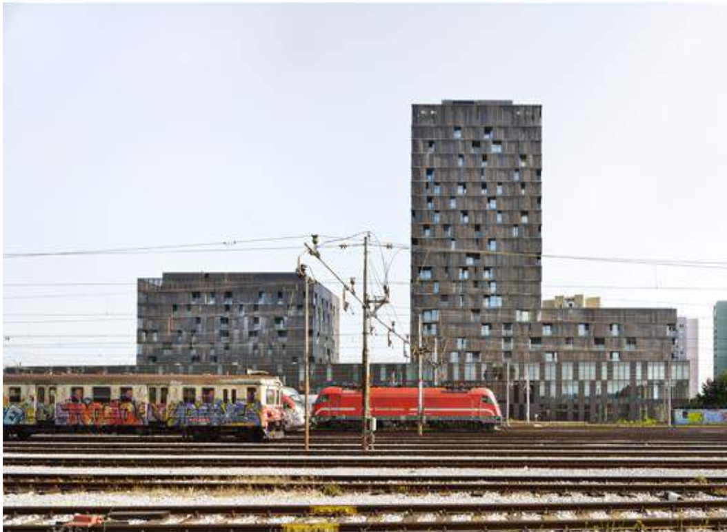
(Fig.1a ) Planimetria e fronte principale visto dalla stazione ferroviaria
