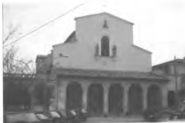
Chiesa di S. Nicola: facciata attuale.
