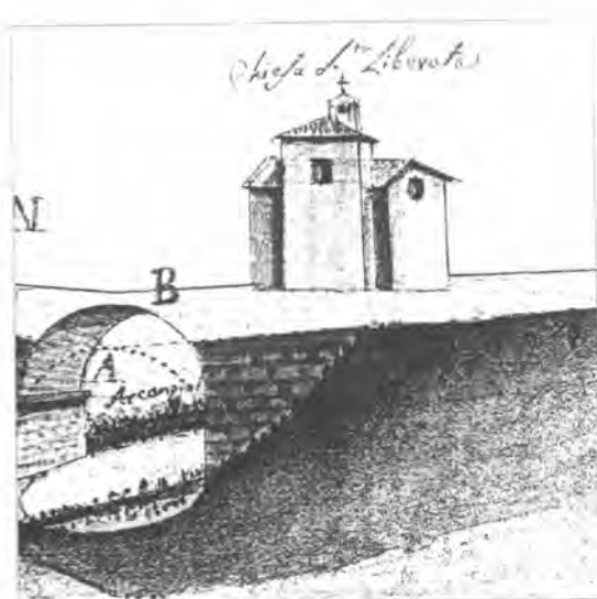
Chiesa di S. Liberata prima della demolizione.
