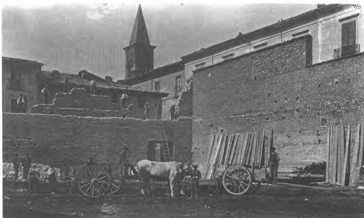
Lavori di costruzione del Teatro Comunale Littorio. Demolizione di murature del convento di Santa Caterina.
