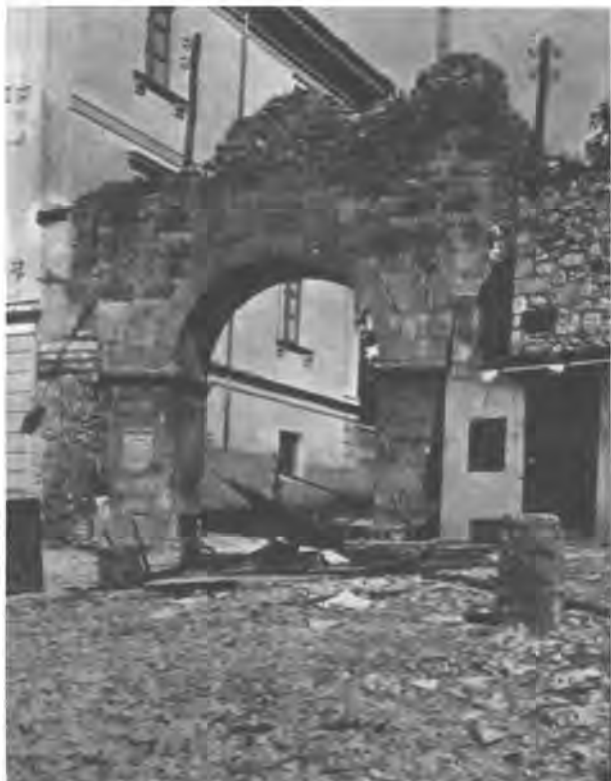
La garitta daziaria di Porta Romana dopo la sommossa del 2 ottobre 1929.
