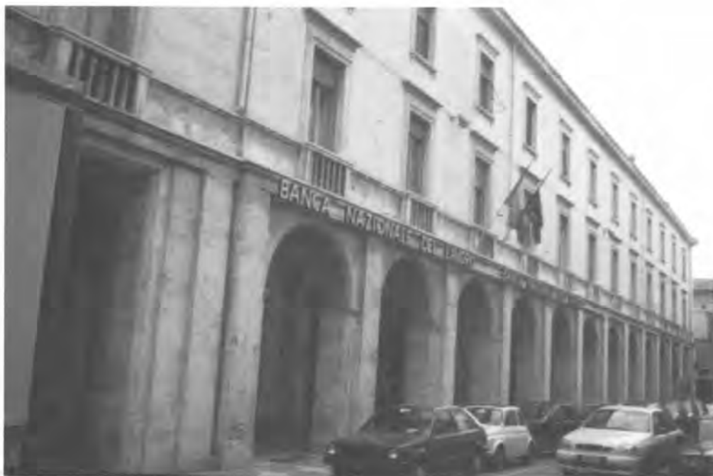
Edificio porticato in via De Nino. Scorcio della realizzazione allo stato attuale. (Foto dell'A.)
