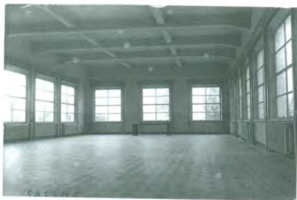
Edificio Scolastico in viale Napoli. Salone.
