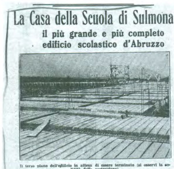
Lavori di costruzione dell'Edificio Scolastico in viale Napoli. Costruzione solaio terzo piano.
