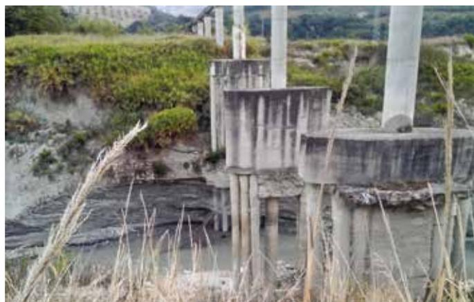
4. Un esempio di fortissima erosione fluviale del Vomano all'altezza di Castelnuovo (TE): le fondazioni originali realizzate con il palo-pila centrale furono consolidate con corona di medio-pali, oggi anch'essi completamente scoperti
