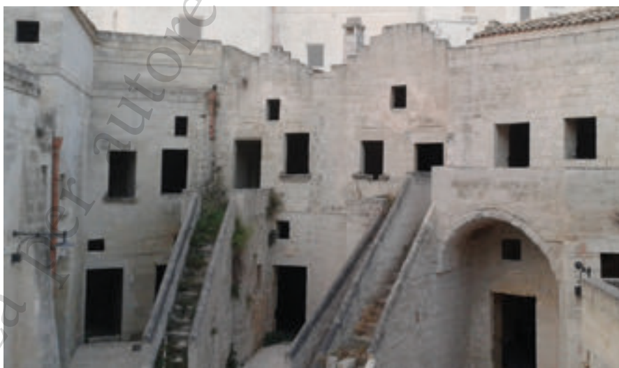
Figure 1: Il Vicinato "Tre Scale" a Matera dopo l'intervento di restauro del 2016, compiuto in seguito a numerosi anni di abbandono.
