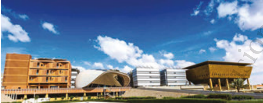
Figura 1: Veduta degli edifici del MIST di Masdar City
