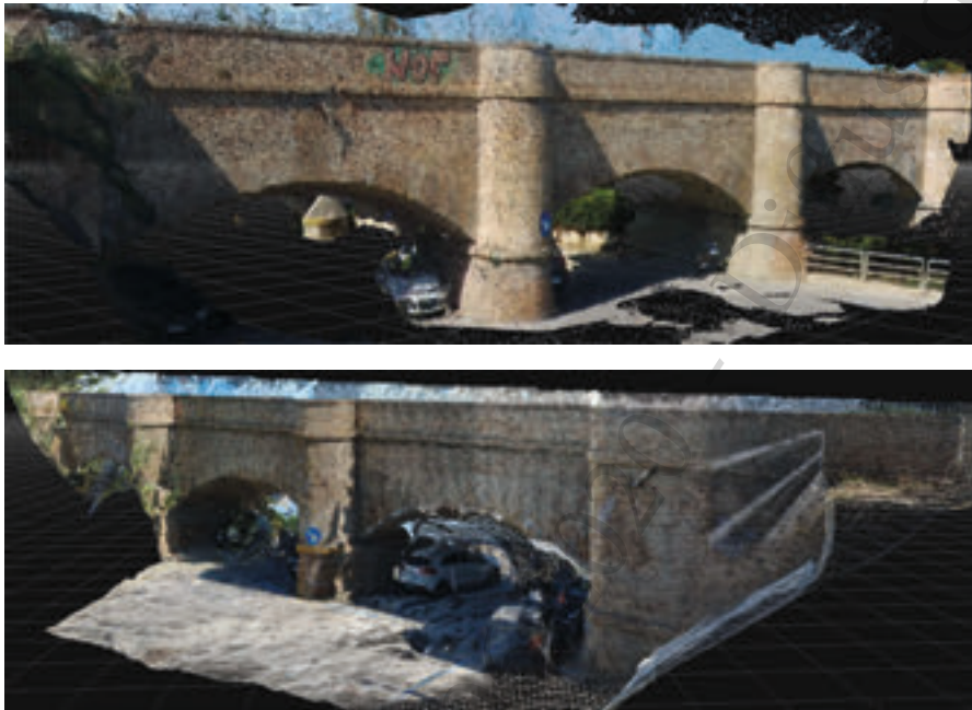
Figura 6: Modello digitale in nuvola di punti (in alto) ottenuto dalla elaborazione mediante software Agisoft Photoscan dei fotogrammi scattati su via Feltrino. In basso il lato opposto del ponte nel modello mesh.
