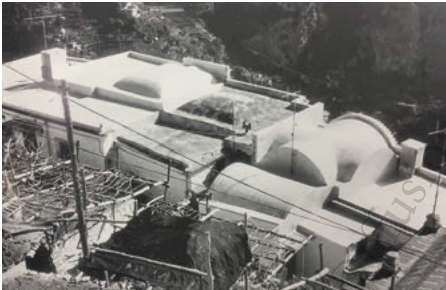
Figure 7: Pogerola (Amalfi), case tardo medievali e del primo Settecento. Si alternano in copertura moderni lastrici piani, volte estradossate a botte, a schifo e a crociera a copertura dei piani residenziali. Tratta da G.FIENGO, La casa medievale della Costa d'Amalfi e le sue stratificazioni moderne, Quaderni dell'Istituto di Storia dell'Architettura, 34-39, 1999-2002
