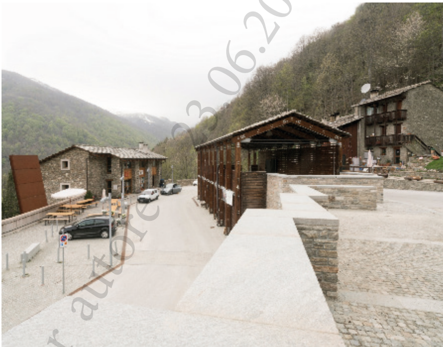
Il Porto Ousitano, la nuova porta di Ostana con spazi pubblici, parete di arrampicata e tettoia per eventi e accoglienza turistica. 2013. Arch. M.Crotti, A.De Rossi, M-P.Forsans (ph. L.Cantarella)
