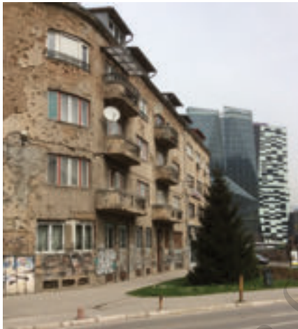
Figure 3: Le facciate di numerosi edifici portano ancora i segni dei proiettili e delle granate
