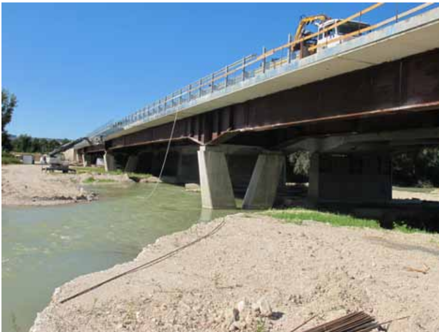
Figura 13 - Il nuovo ponte sul Chienti a Montecosaro
