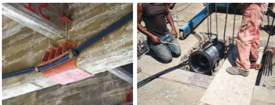
10A e 10B. La precompressione esterna del Gibe River Bridge, Etiopia (Salini-Impregilo)
