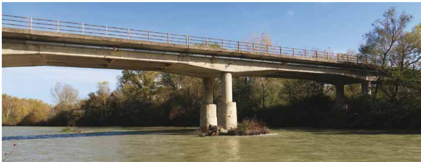
11. Un dettaglio dei collari delle pile del ponte Nuovo sul Sangro
