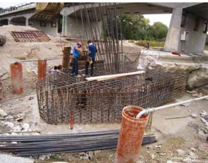
14A e 14B. Il ponte di Montecosaro
