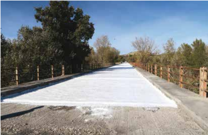
12. L'applicazione della guaina liquida presso il ponte Nuovo sul Sangro
