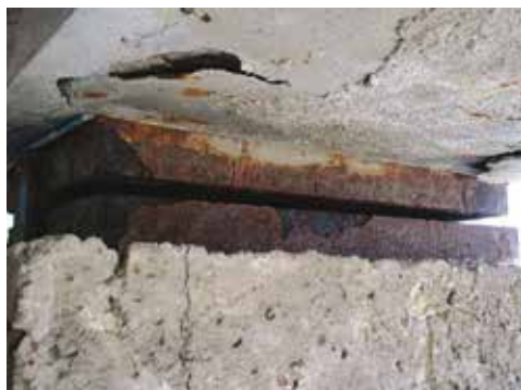
8A e 8B. Dettagli del deterioramento degli appoggi
