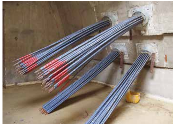
9. Il trefolo protetto con resine
