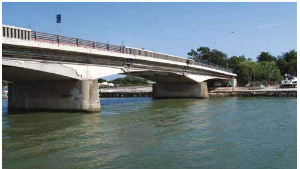
13. Il ponte della Scafa
