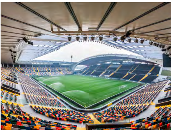
Udine, Stadio Friuli, il recente intervento di adeguamento della copertura ( https://it.wikipedia.org ).
