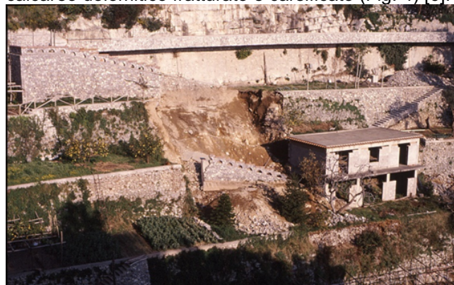
Fig. 1 – Tipica frana che ha coinvolto muri a secco sulla Costiera Amalfitana
