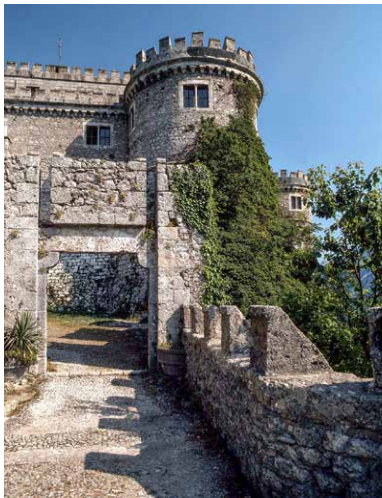
150. Sotto: l'ingresso al castello Piccolomini di Balsorano (AQ).
